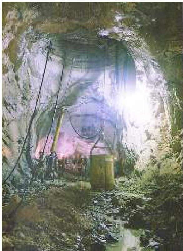
Hĺbenie novej šachty v Gelnici - Thurzov nar. 31 horizont
